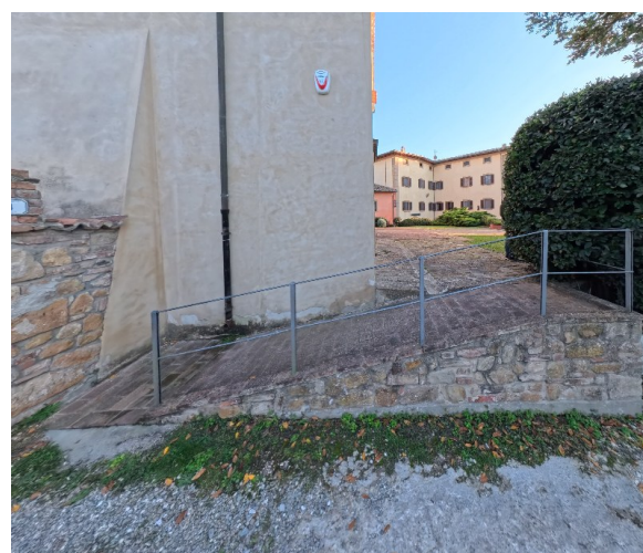
6 rampa laterale Chiesa
